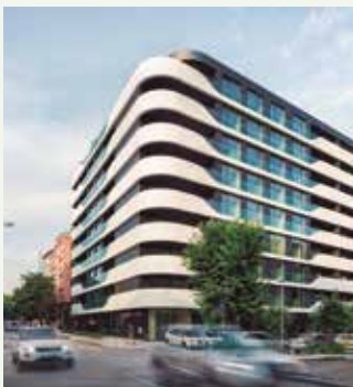
Markantes Wohngebäude mit hocheffizienter Systemlösung für Heizen und Kühlen, Bulgarien. Aquarea
